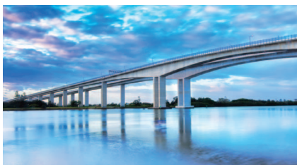
桥梁的劣化监测
